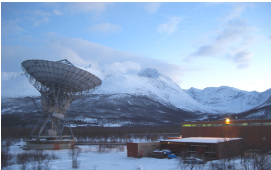
図 2.2: ノルウェー・トロムソに設置されている EISCAT UHF レーダー（左）とコントロール建物（右手前）。送信ビームを磁力線方向に固定して電離圏物理量の観測をする様子。
