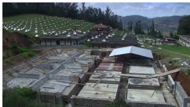
図 1 新ミュオン検出器（2018 年 8 月現在）。写真手前が北。建屋の壁構造の大半が完成している。この後、天井部（吸収層）の建設が行われる。
