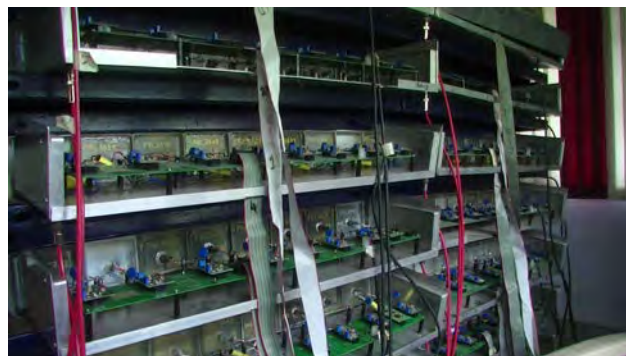
図2 ストレージルームに置かれた比例計数管に新型フロントエンド回路が取り付けられ、試験が行われている。
