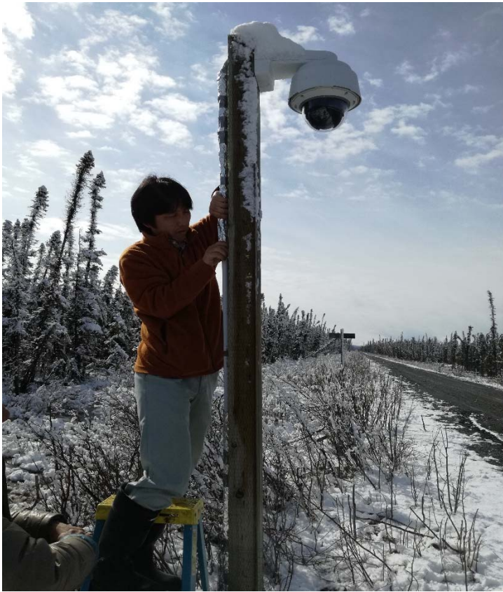
応急処置後のセキュリティカメラ。 カメラ部分はチキンワイヤーで覆った。 The security camera after shielding.
