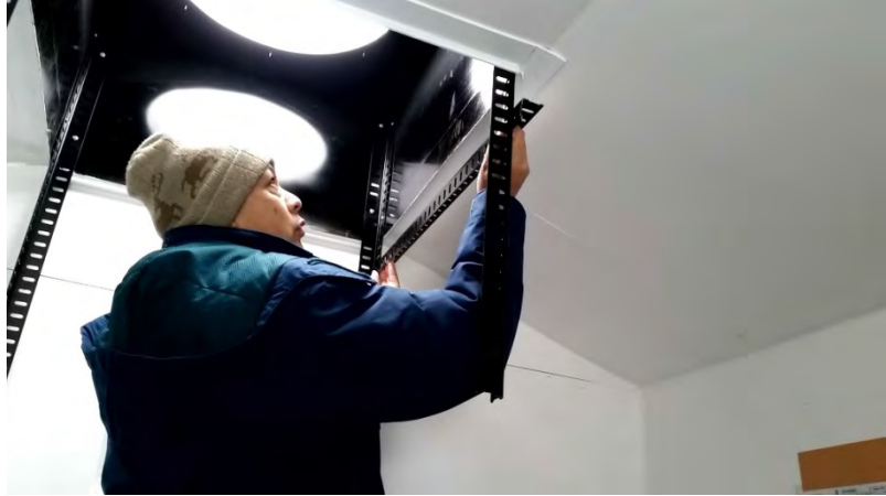
カメラを固定するためのアングルを取り付けます。 We attached L-angles to set the camera.
