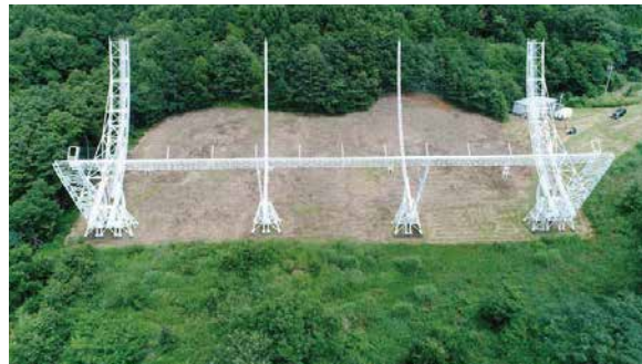
木曽観測施設の IPS 電波望遠鏡の空撮画像
