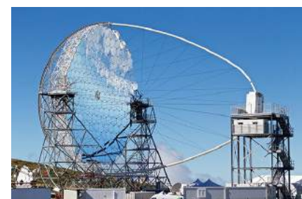
大口径望遠鏡1号機。198枚の分割鏡で、直径23mの放物面鏡を構成している。写真右側には直径2mの焦点面カメラが取り付けられている。
