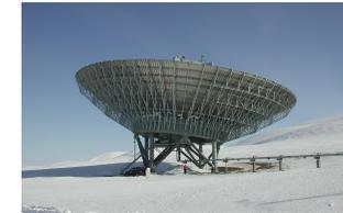
ロングイヤービエン (78.15° N, 16.05° E) に設置。アンテナは可動式 (直径 32 m) と沿磁力線方向固定式 (直径 42 m) の2基より構成。VHF、UHFレーダーに比べ高緯度に設置されているため、太陽風粒子が直接流入するカस्प域や、ポーラーキャップにおける物理現象の観測に適する。
