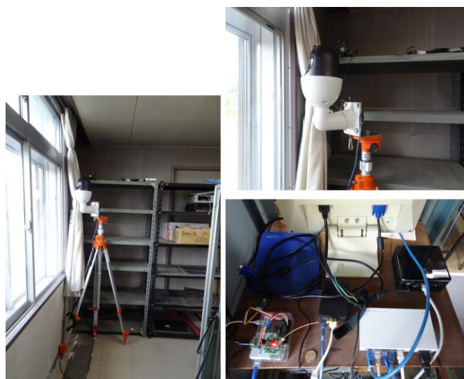
図1 鹿児島観測所設置システム外観
