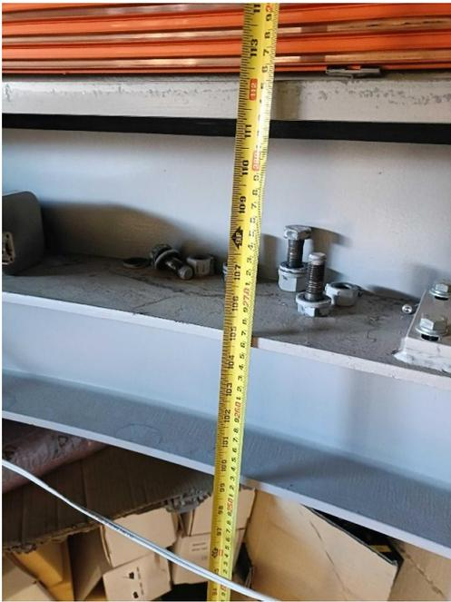
図 1. ESPRIT 設置において最も懸念されていたドーム内の梁。この梁の間に ESPRIT のコールドヘッド (図 2) が収まる配置設計となっている。メジャーで計測した梁間のスペースの床からの高さは 2670~2830mm で、設計図に基づいて設定した CAD 上の梁間のスペース (2655~2855mm) より若干狭いが、実測に基づいて再設計した CAD データにおいてコールドヘッドが入るには十分であることが確認された。
