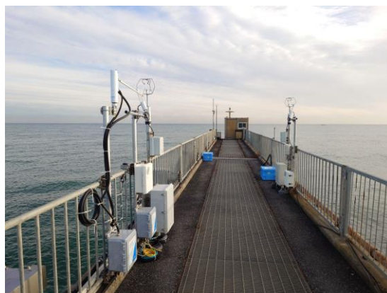
図1 波崎海洋観測施設の観測栈橋に設置した乱流フラックス観測システム
