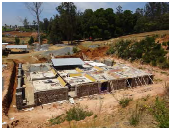
図 1 新ミュオン検出器（2018 年 3 月現在）。写真右側が北。建屋の壁構造の大半が完成している。この後、天井部（吸収層）の建設が行われる。
