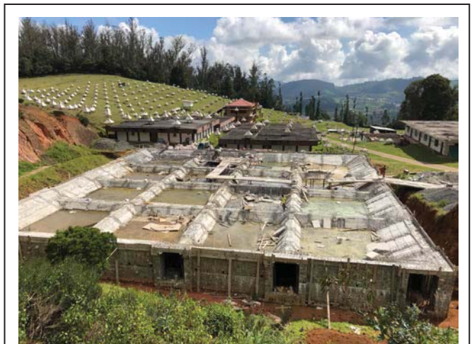
図 1 新ミュオン検出器（2019 年 11 月現在）。写真手前が北。建屋の壁や天井部の構造が完成している。この後、天井の上に吸収層の建設が行われる。
