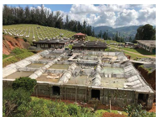
図 1 新ミューオン検出器（2019 年 11 月現在）。写真手前が北。建屋の壁や天井部の構造が完成している。この後、天井の上に吸収層の建設が行われる。
