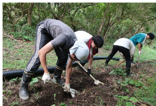
図2 佐多観測点でケーブルを埋設するための穴掘り作業
