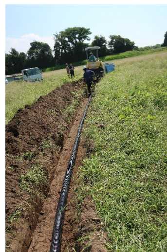
図1 重機を使ったケーブル敷設
