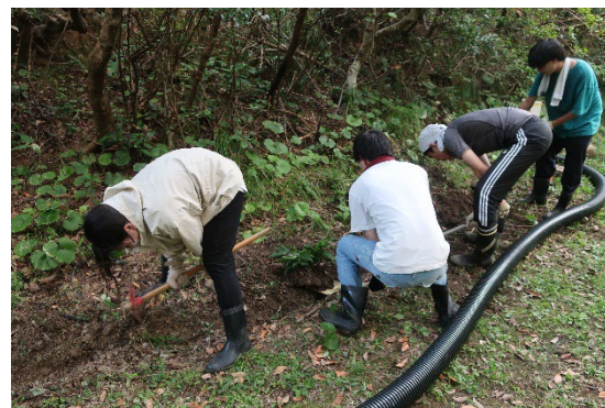
図2 みんなで掘ったケーブル敷設
