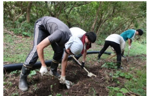
図2 ケーブルを埋設するための穴掘り(佐多観測点)
