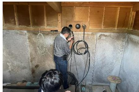
図1 上の台地観測点でケーブルを地下パイプに這わせている様子。
