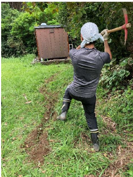
図1 ピッケルで穴を掘り進める様子
