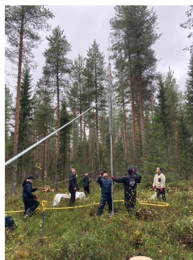
図 1 リオメータ設置作業の写真
