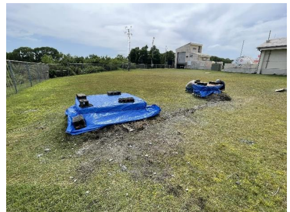
図2 最終的な設置状況。
