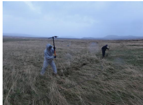
写真 1：Húsafell 観測点でのケーブル埋設の様子
