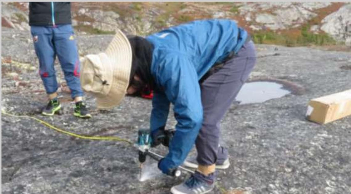
岩盤に穴をあけ、アンカーボルトで固定します。
