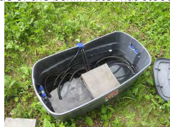
ボックス内部。水浸し状態 Inside of the box...Water has stood
