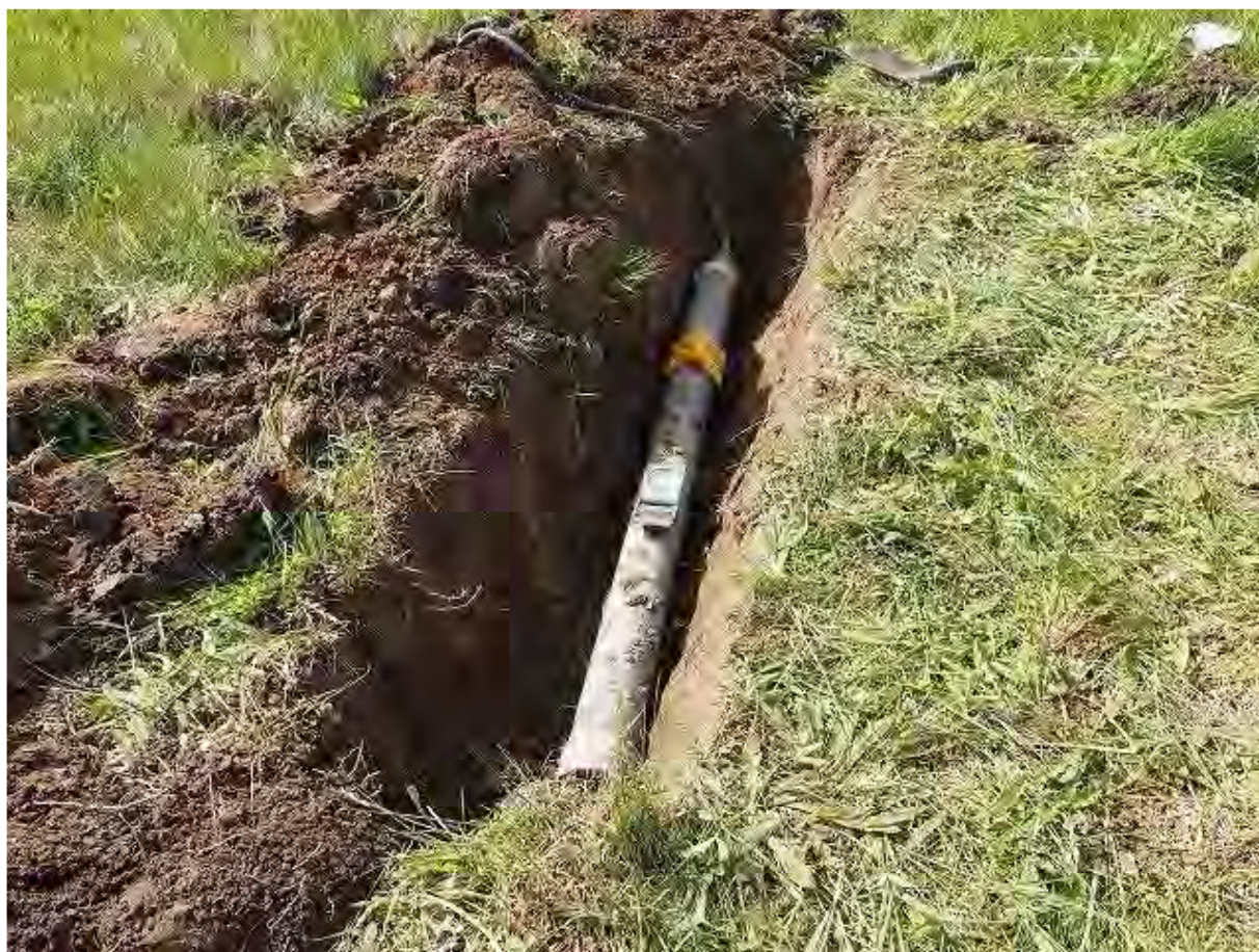
新しい穴に設置された誘導磁力計センサー The sensor settled into the new hole
