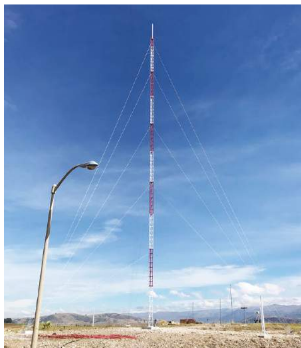
ペルーに設置された電離圏観測用 FM-CW レーダー
