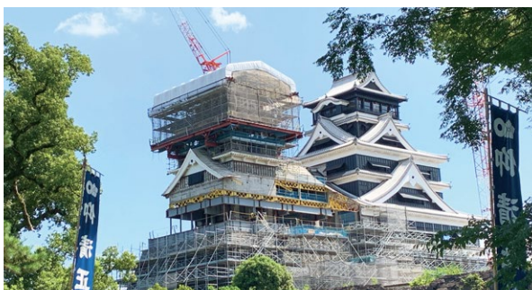
熊本城 修復工事の様子
