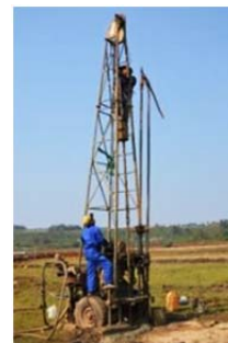
ベトナムでの掘削。
