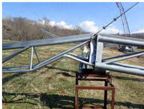
被害を受けた富士アンテナの反射面。
