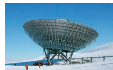
ロンゲイアピン（北緯 78.2 度）にある欧州非干渉散乱（EISCAT）レーダー。 The 42-m antenna of the EISCAT Svalbard radar.
